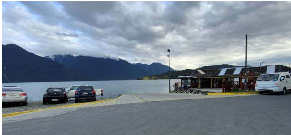
Imagen 17. Rampa de Hornopirén
