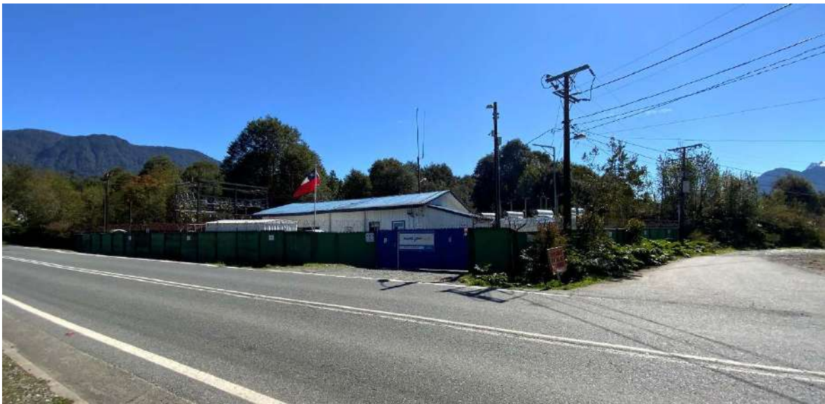
Imagen 20. Planta Térmica Hornopirén
