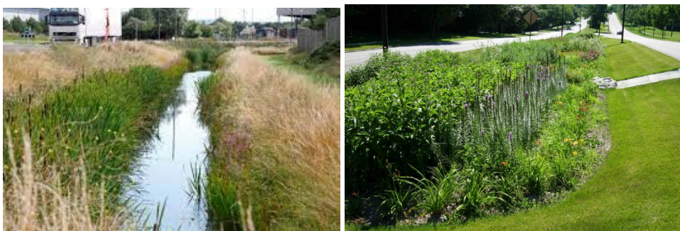
Imagen 4. Ejemplos de bioswales que recorrerán áreas verdes asociadas a vialidades
